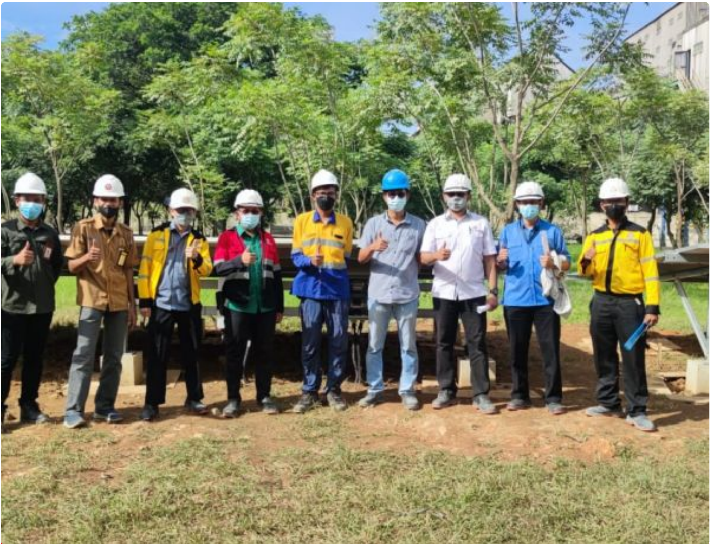
PT Semen Tonasa pasang PLTS 10 Kwp di Tonasa 5
